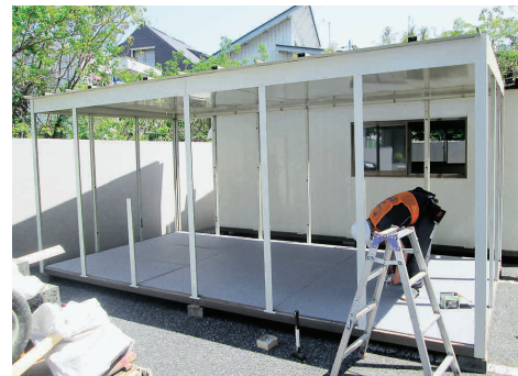
ハウスの枠組み完成
