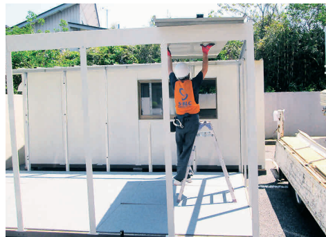
屋根パネルの設置工程
