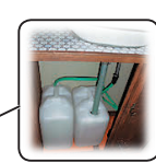
給水タンクと 排水タンク
