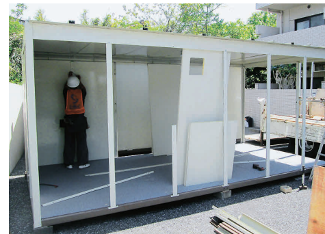
壁パネルの設置
