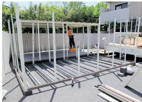
土台・レベル調整後・柱建て上げ
